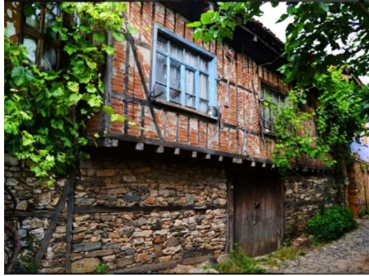
Figure 21 Hımış house, Cumalıkızık, Bursa
