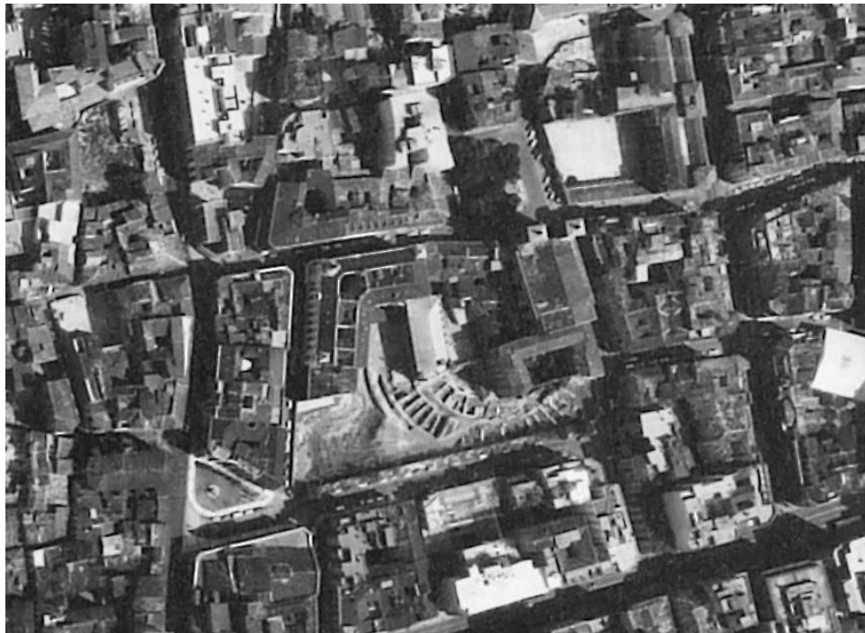
Figure 3 Block 11 before demolition for a new construction. Source: GAZA, Gran Archivo Zaragoza Antigua
