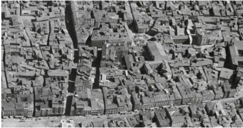
Figure 2 Block 11 before demolition for a new construction. Source: GAZA, Gran Archivo Zaragoza Antigua
